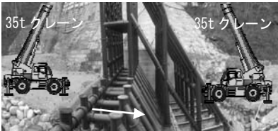
写真-1 越百川第3砂防堰堤 施工イメージ
