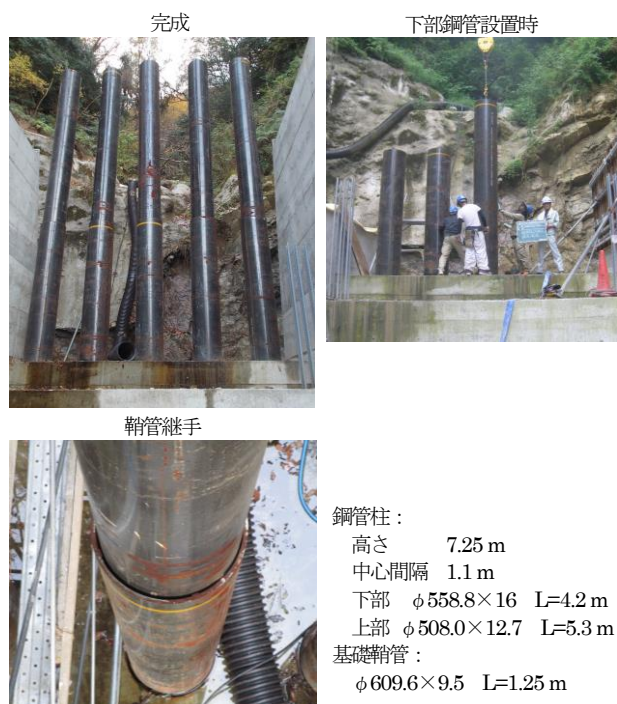
図-5 鋼管林立構造例①
