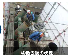
④撤去後の状況
