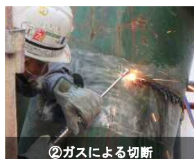
②ガスによる切断
