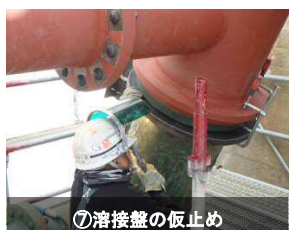
⑦溶接盤の仮止め
