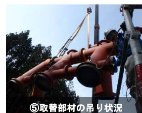
⑤取替部材の吊り状況
