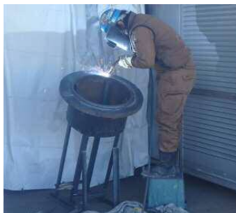
写真-3 傾斜方向（1:0.5）の溶接
