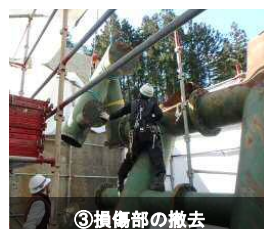
③損傷部の撤去
