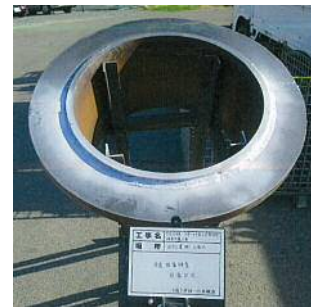
写真-4 浸透探傷試験
