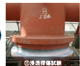
⑪浸透探傷試験
