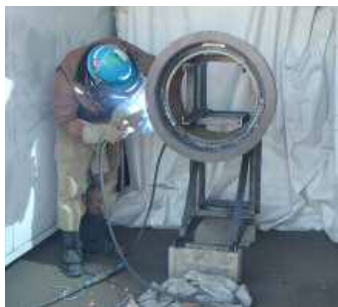
写真-2 水平方向の溶接
