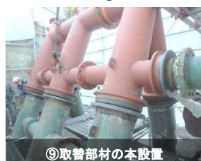
⑨取替部材の本設置
