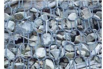
図6 リングネット変形状況
