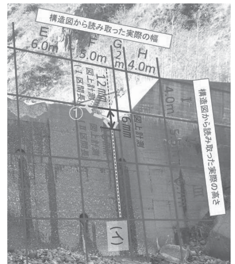
図-2 変位量の測定例
