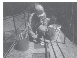
写真-2 砂防堰堤天端における試験状況
