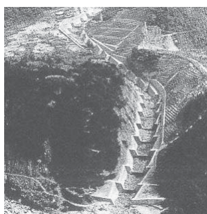
泥谷砂防堰堤群
