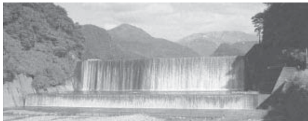
本宮砂防堰堤(本堰堤および第1副堰堤)
