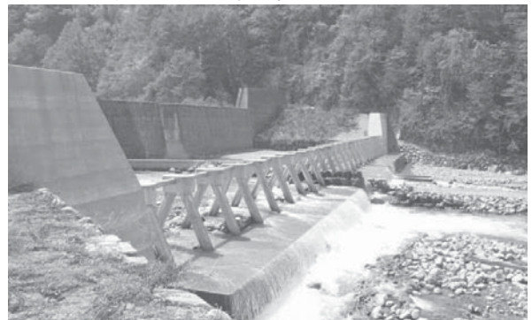
写真-1 跡津川流木対策工（H26完成）
