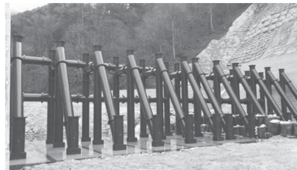
写真4 第1期施工範囲の完成検査時の状況
