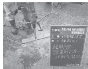
写真3 アンカー施工状況
