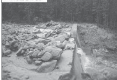
写真-2 土石流発生後
