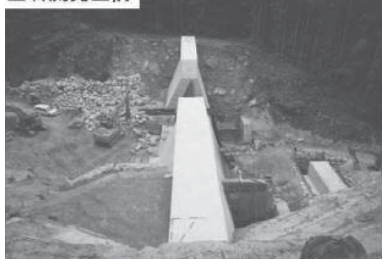
写真-1 土石流発生前
