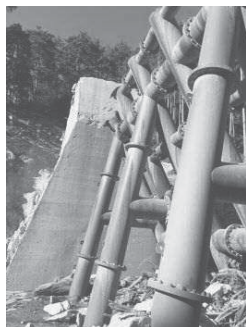
写真-4 下流部材の状況
