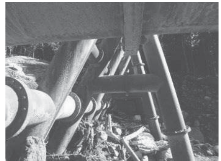
写真-6 断面の状況
