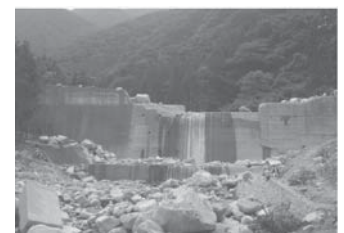
写真-4 コンクリート堰堤の事例
