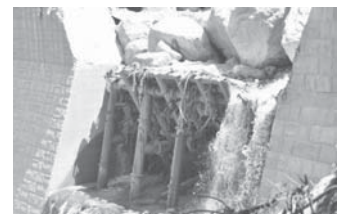
写真-2 鋼製透過型堰堤の事例 1
