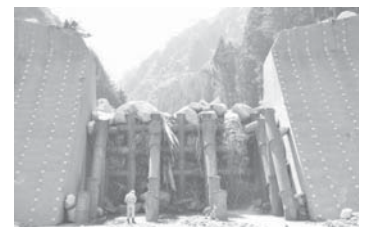
写真-3 鋼製透過型堰堤の事例 2
