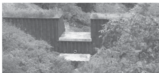
写真-1 下半張出部を設けた施工事例
