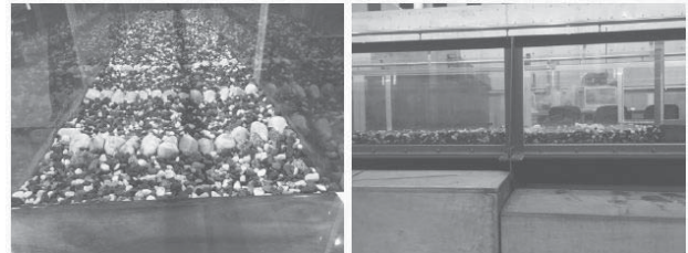
a) 上流から下流側を見た状況 b) 側面から見た設置状況
