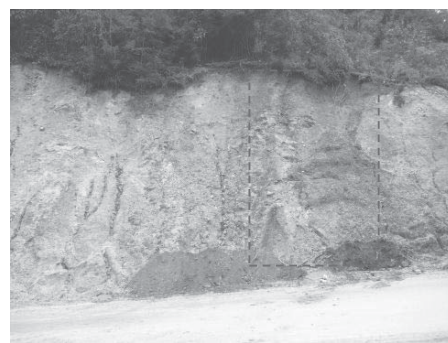
写真 3.1 施工前斜面(点線：施工予定範囲) (2014.10.20)
