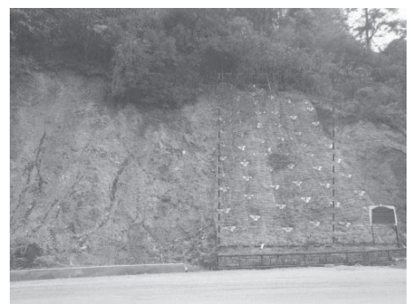
写真 3.2 施工 7 ヶ月後の斜面 (2015.10.30)
