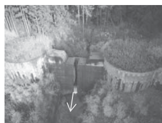
写真-2 鋼矢板の変色
