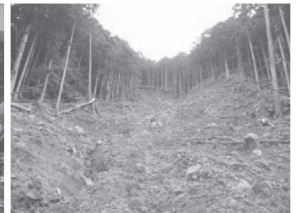
写真-2 山腹崩壊(左支川1)の事例
