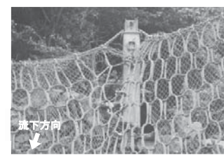
図 12 リング状ネット変形状況
