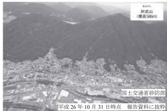
写真 1 被害状況（空中写真）
