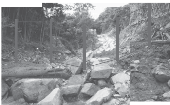
写真 2 現地踏査状況
