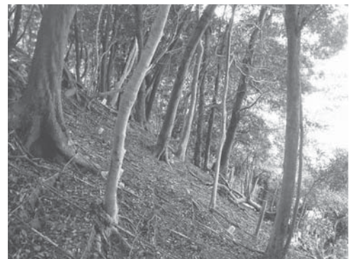
図 1 本工法の施工状況
