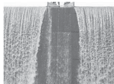
図-1 ベニヤ板による締切状況
