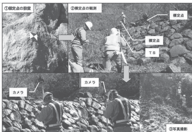
図 3 西谷堰堤測量及び写真撮影状況
