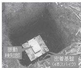
写真-1 検知部設置状況
