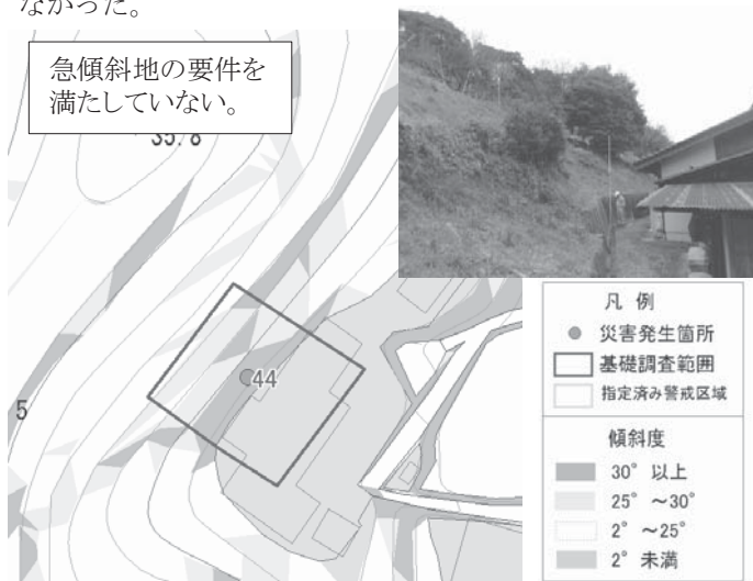
図-1 災害発生箇所の状況(がけ崩れの事例)
