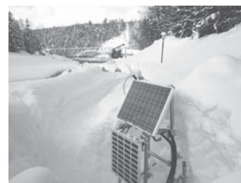
図-3 振動センサー設置状況（上流側）
