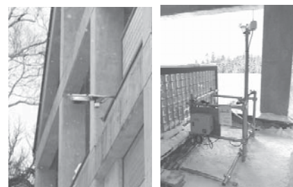
図-4 測域センサー等設置状況
