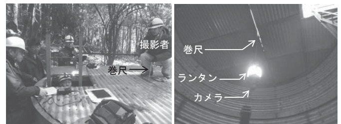
図-7 カメラの吊り下ろし状況
