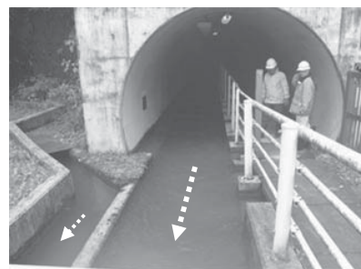
写真－2 トンネル魚道入口
