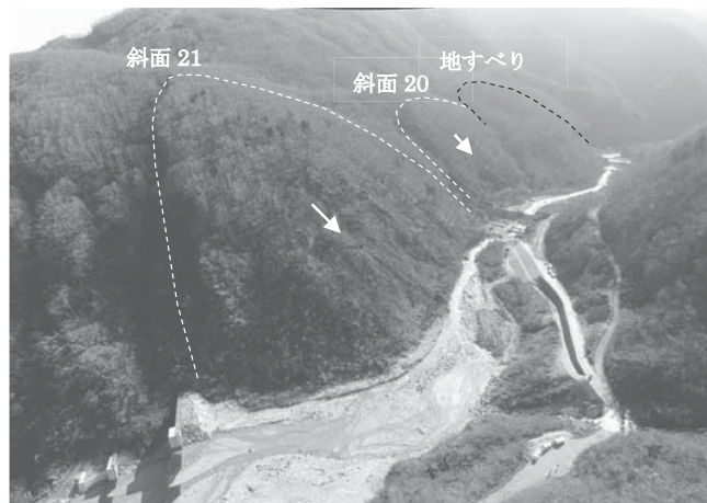
図1 詳細調査を行った斜面の斜め空中写真 (平川)
