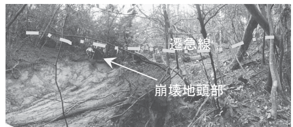
写真1 崩壊地頭部の現地状況（図3の崩壊地9）
