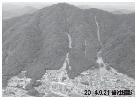
写真-1 山麓斜面に近接する宅地と土砂災害 (広島市八木西地区)
