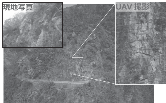
図-4 点検対象斜面の UAV による撮影例 (浮石の状況)
