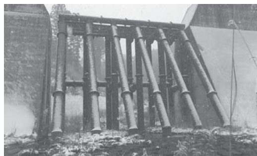
写真-1.2 新湯川砂防堰堤（平成28年調査時）
