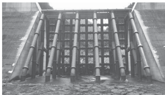
写真-2.2 幕川砂防堰堤（平成28年調査時）
