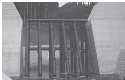
写真-1.1 新湯川砂防堰堤（平成21年竣工直後）
