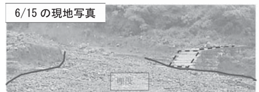
図-9 B地点における土石流終息時とその後の現地状況
