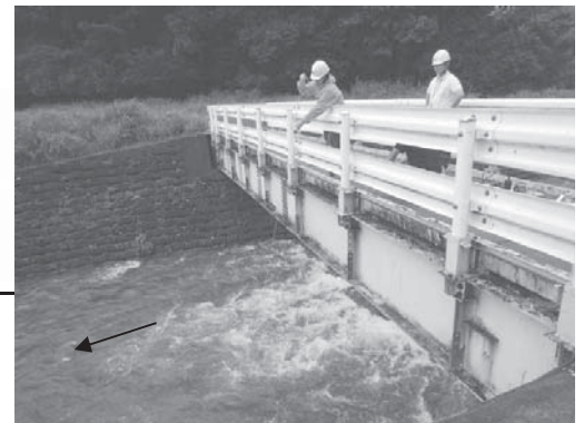
写真-3 下流側の観測箇所
