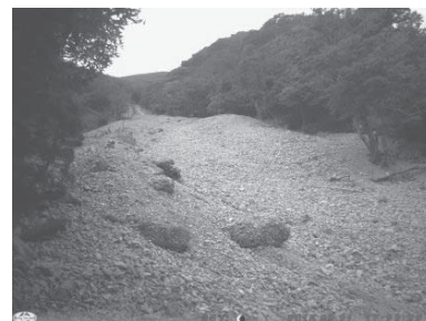
図-2. 西之貝戸川第一右支川の土石流発生域
