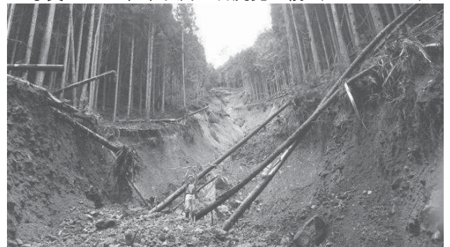
写真-3 中坪下沢土石流発生後 (H27. 9. 11)
