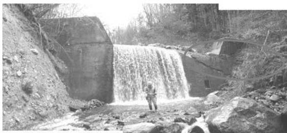
写真-1 小赤沢第1号砂防堰堤全景
