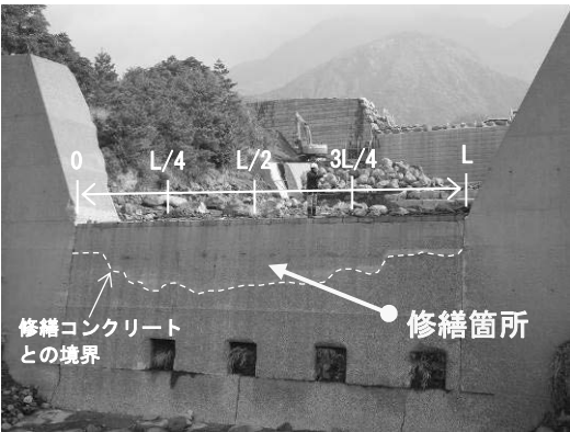
写真 1 水通しの修繕事例と計測位置
