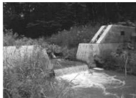
写真 1 えん堤周辺の流況
