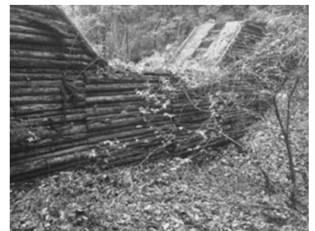
写真 1 砂防堰堤（上流）の写真
