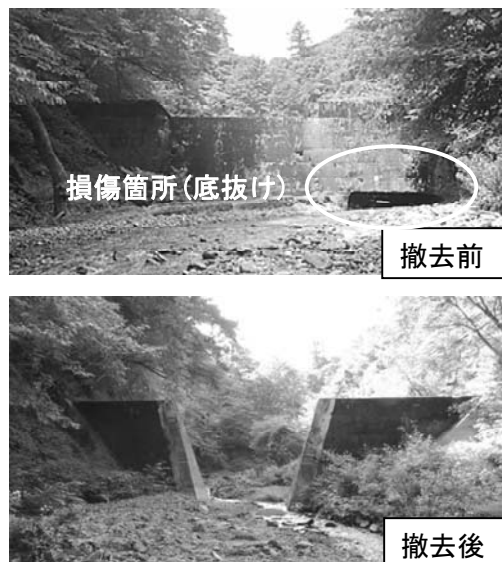
写真 1 撤去前後の No. 2 ダムの状況
