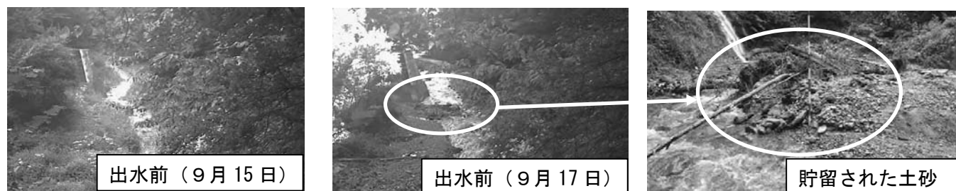
写真 2 平成 25 年 9 月の出水に伴い No. 2 ダム上流側に貯留された流出土砂の状況
