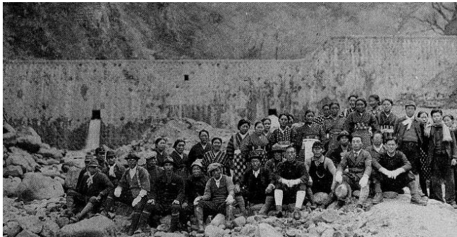
写真-1 濁沢第2砂防堰堤竣工時の写真（石工以外の作業員の多くを女性が占めている）
