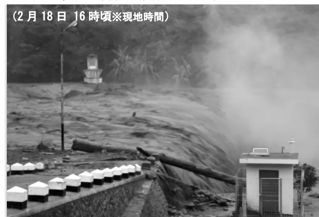
写真2 Konto 川における砂防堰堤の状況
