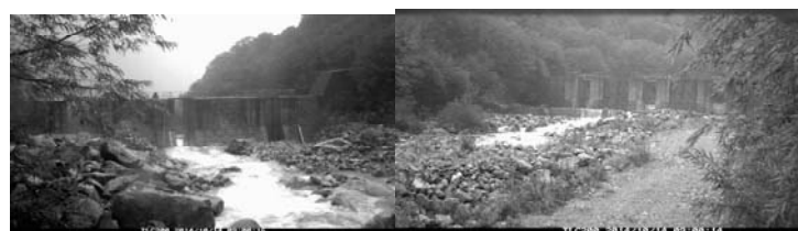
写真-1 出水時の撮影写真 (2014年10月14日9:00)
