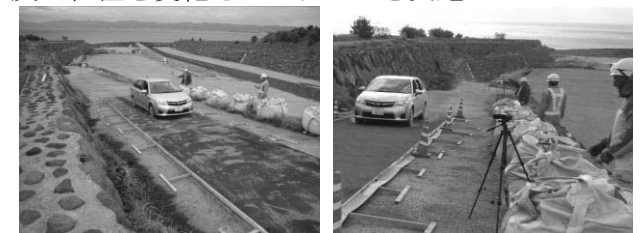
写真 2-2 登坂能力試験状況
