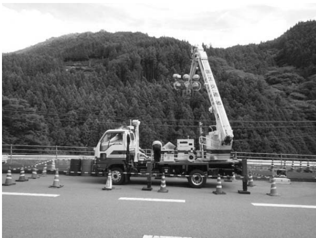
写真1 照明車、衛星通信装置による斜面監視
