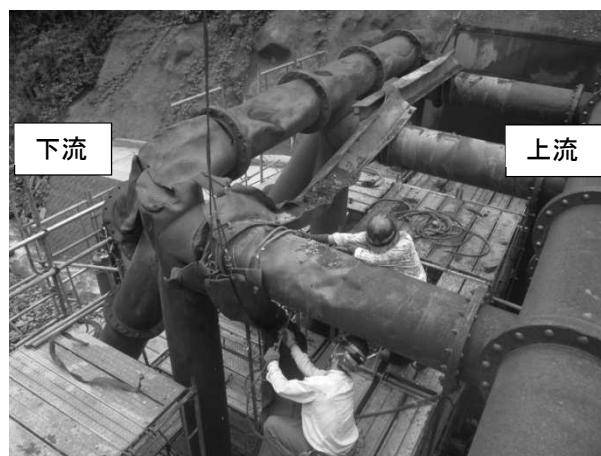
写真 1 部材の撤去状況
