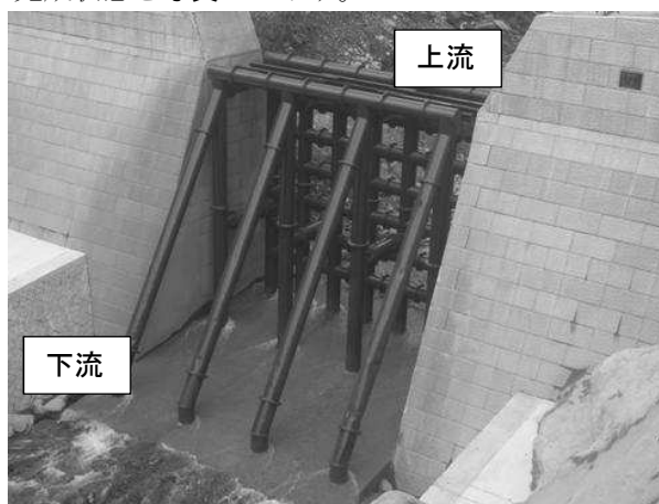
写真4 補修工事完了時
