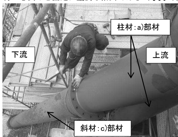
写真2 柱材の架設状況
