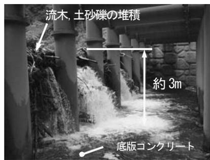
写真-1 堰堤上流側の堆積状況
