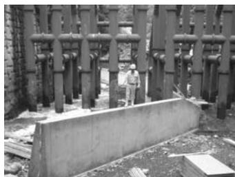
写真-5 仮設工(半川締め切り)
