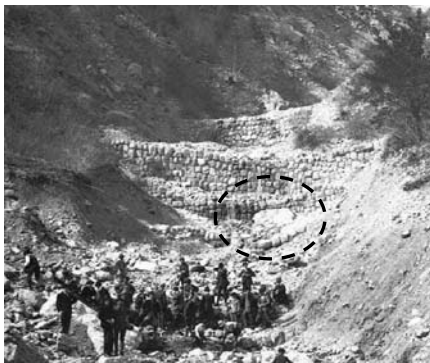
写真4 Manival 溪 (上流の石積堰堤, 左: 1921 年撮影 7) , 右: 現在 2014 年)
