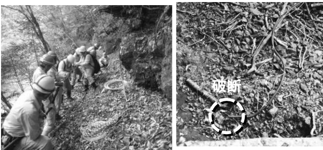
写真-1 (左) 通信ケーブル敷設状況 (右) 通信ケーブル破断状況 (栗平地区)
