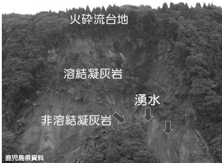
図1 2010年に鹿児島県南大隅町で発生した深層崩壊
